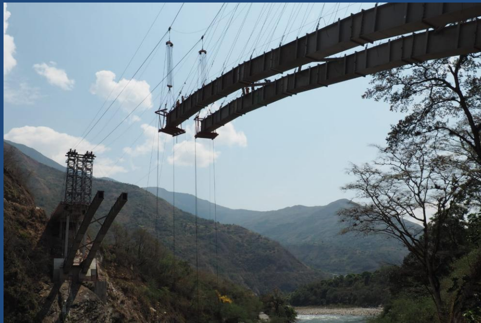
Puente de Maranura. Montaje cimbra
