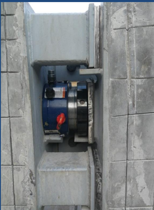
Final de la maniobra de puesta en carga.
