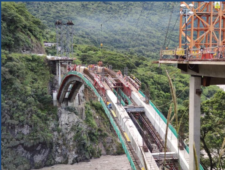
Arco en fase intermedia de hormigonado
