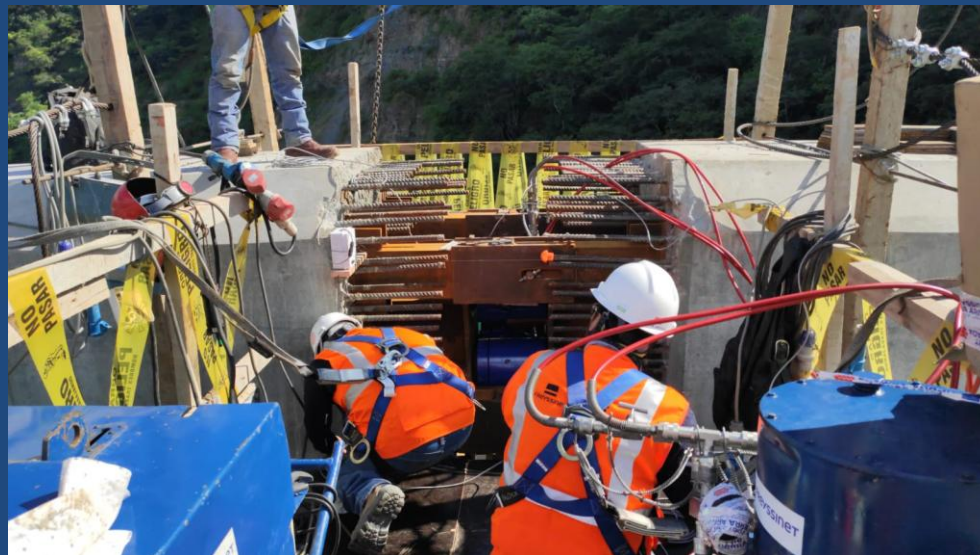
Preparación de maniobra de puesta en carga del arco de hormigón.
