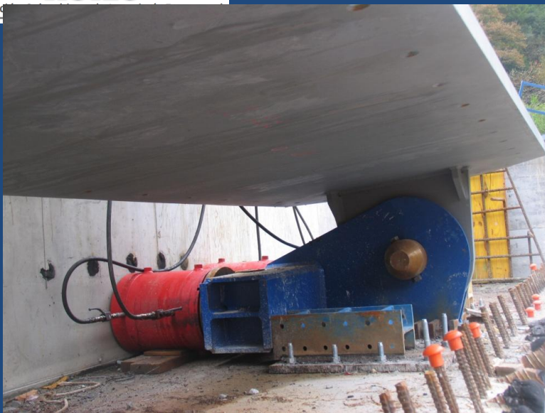
ROTULAS PROVISIONALES EN ARRANQUES DE SEMIARCOS
