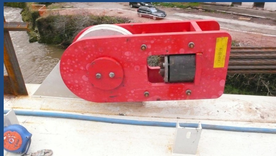
ROTULAS DE ANCLAJE DE LOS TIRANTES
