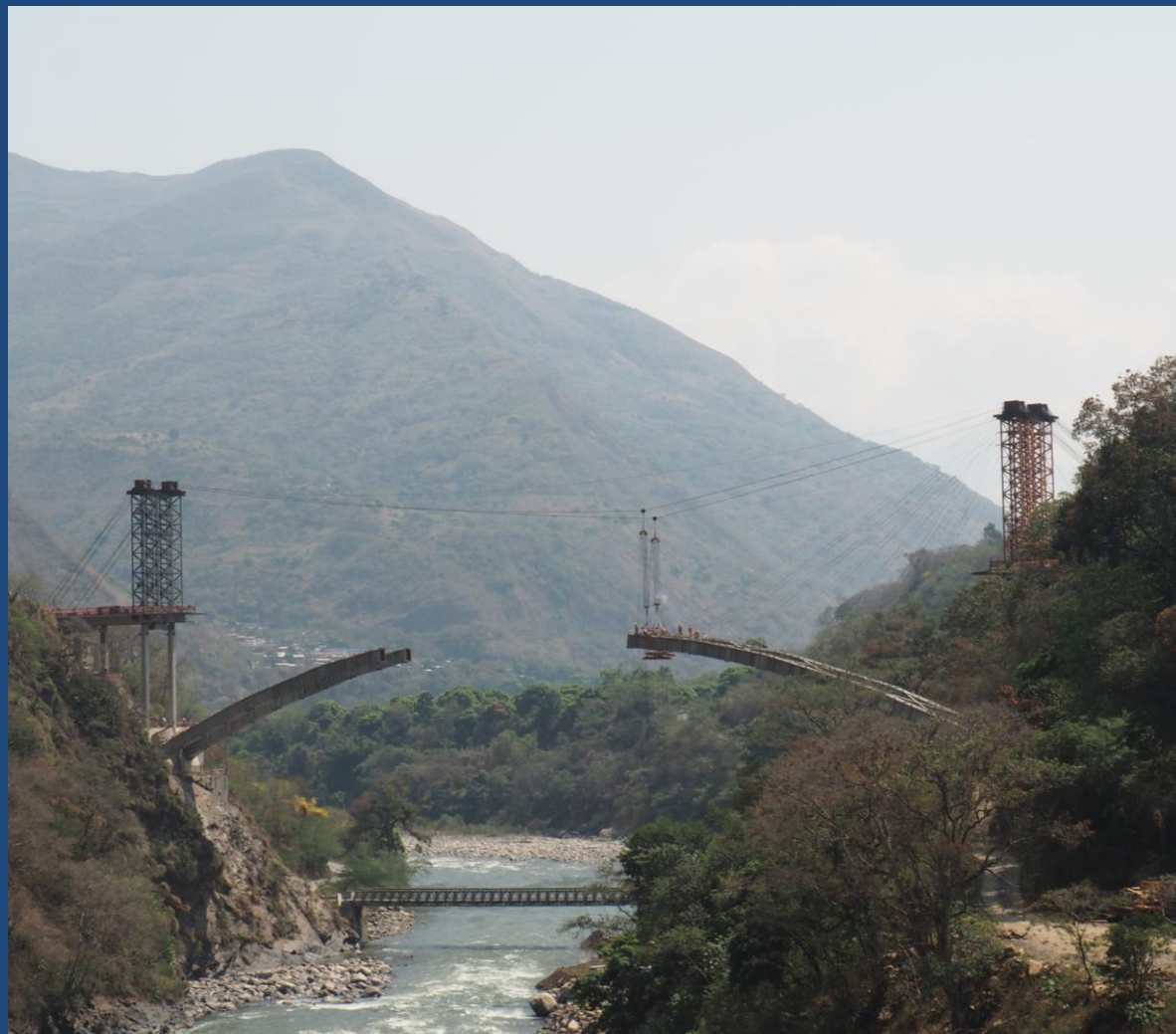
Puente de Maranura. Montaje cimbra
